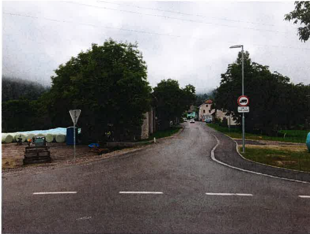
Slika 5: Pogled na rekonstruirano bivšo regionalno cesto (prekategorizirana v LC), ki je potekala skozi vaško jedro Godoviča
