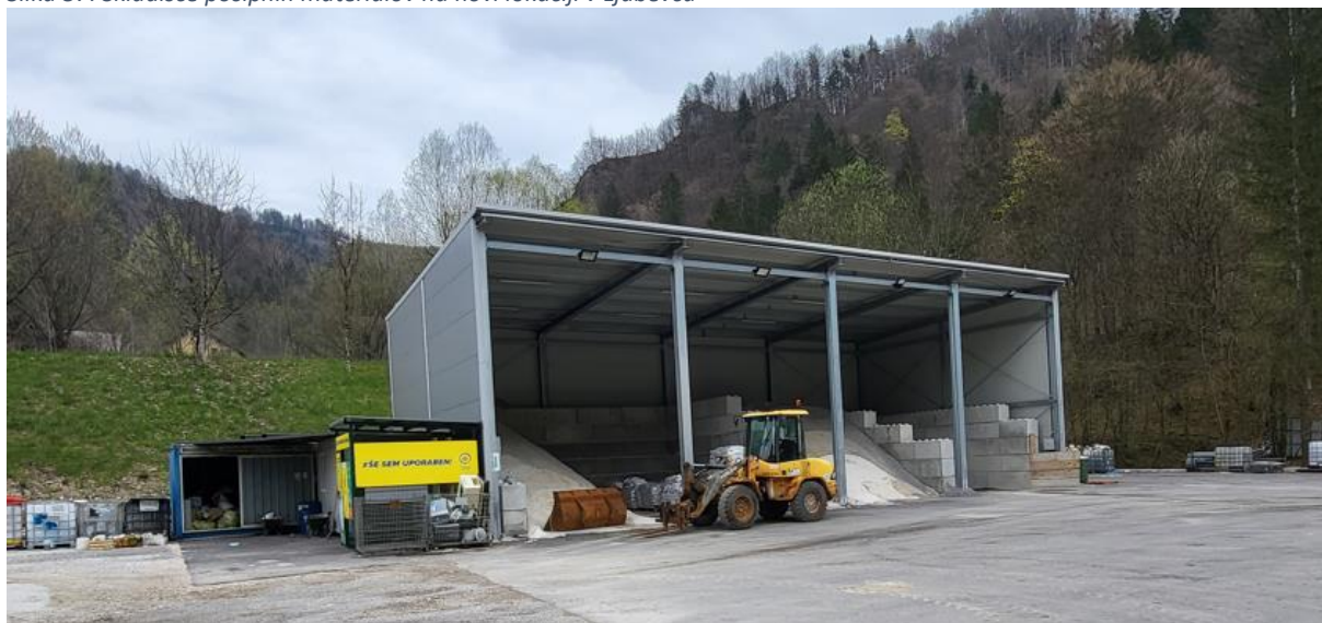
Slika 37: Skladišče posipnih materialov na novi lokaciji v Ljubevču
