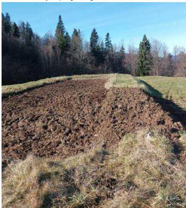
Slika 52: Območje zaprtega odlagališča Raskovec – vzdrževalna dela na biofiltru
