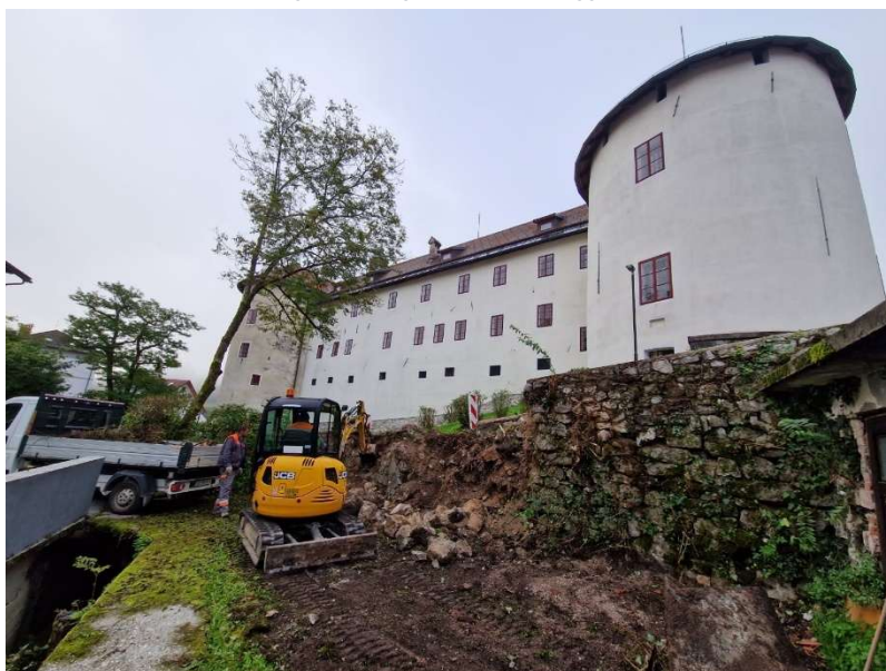
Slika 47: Obnovitev podpornega zidu pri gradu Gewerkenegg
