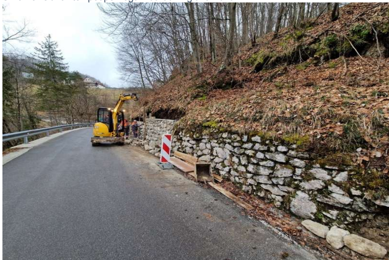
Slika 48: Obnovitev podpornega zidu ob Triglavski ulici
