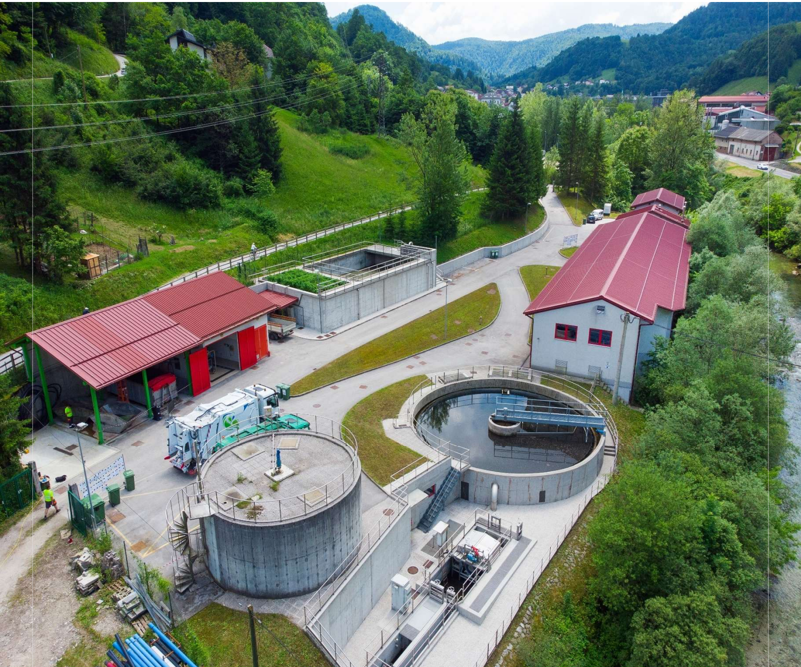
Slika 33: Čistilna naprava Idrija
