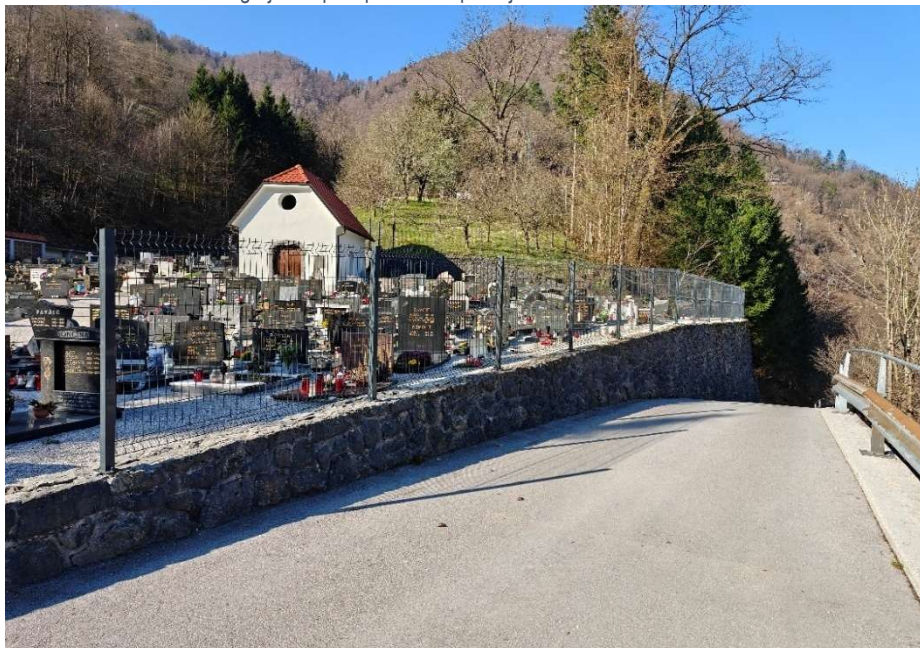
Slika 50: Postavitev nove ograje na pokopališču v Sp. Idriji
